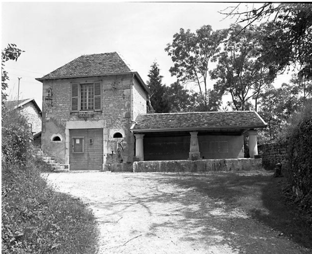
Fontaine-lavoir située rue des Vignerons.
