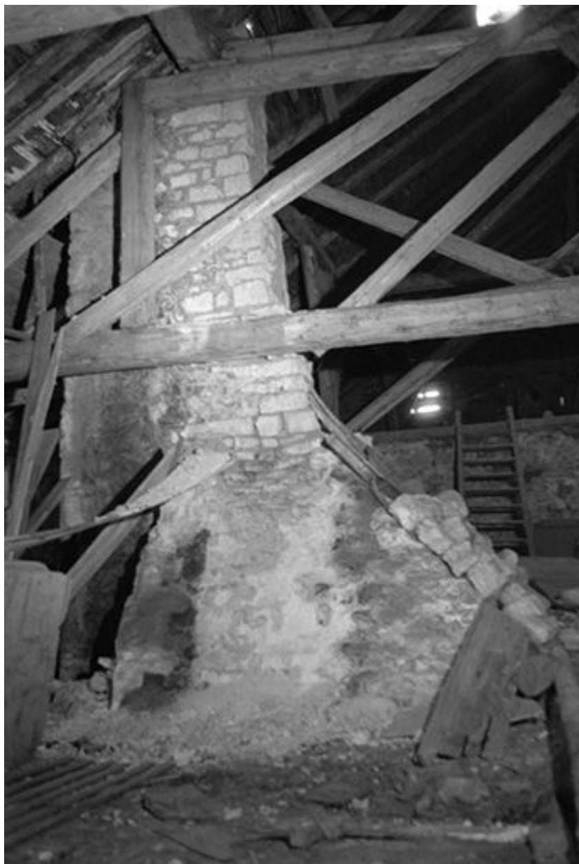
Intérieur : charpente et cheminée.
