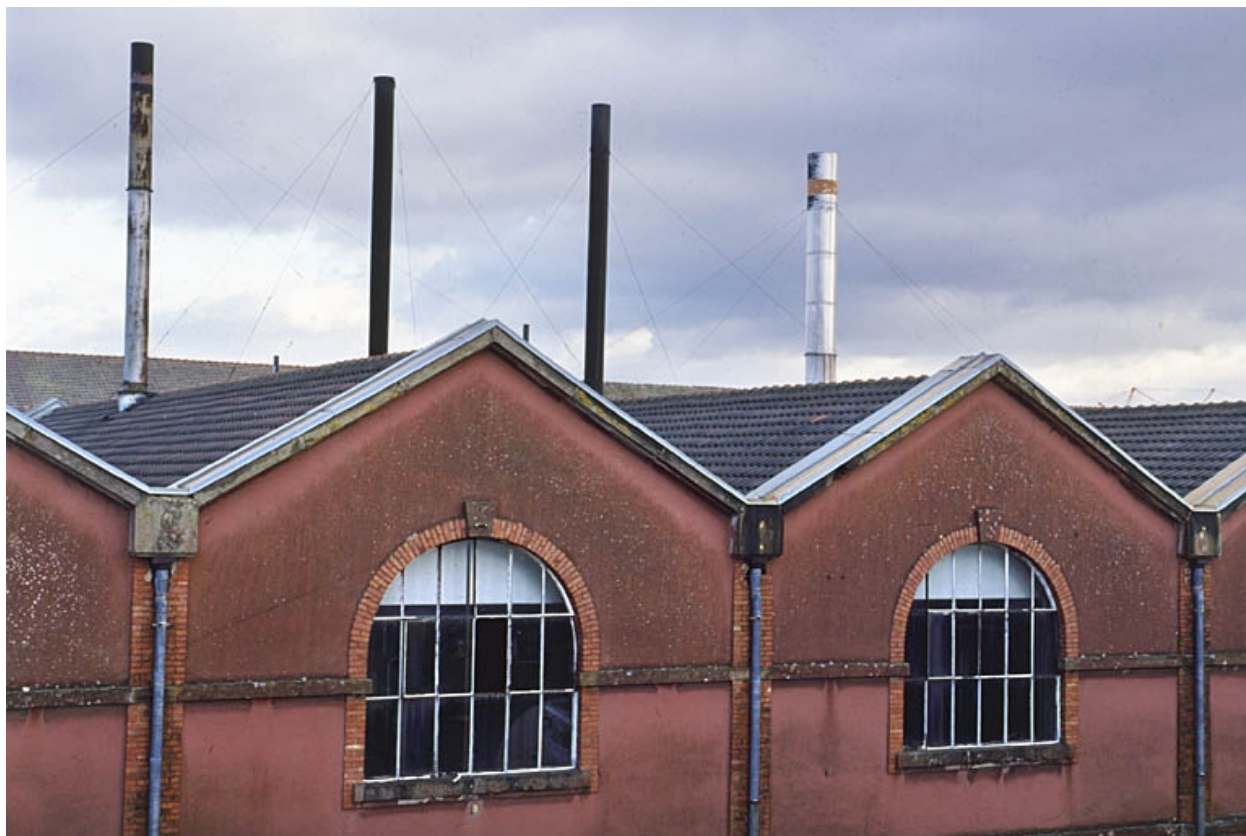
Chaufferie : détail des pignons ouest.
