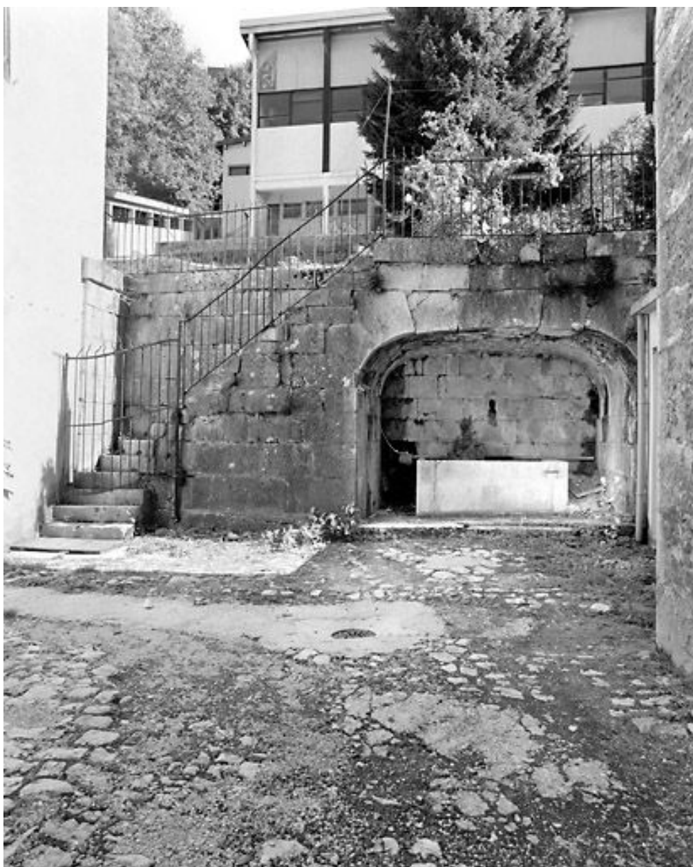
Mur de soutènement, escalier isolé et fontaine.
