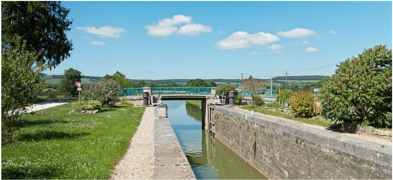
Vue du pont depuis l'amont.
