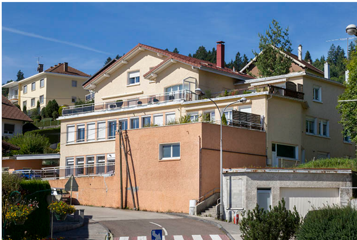
Façades antérieure et latérale droite.
