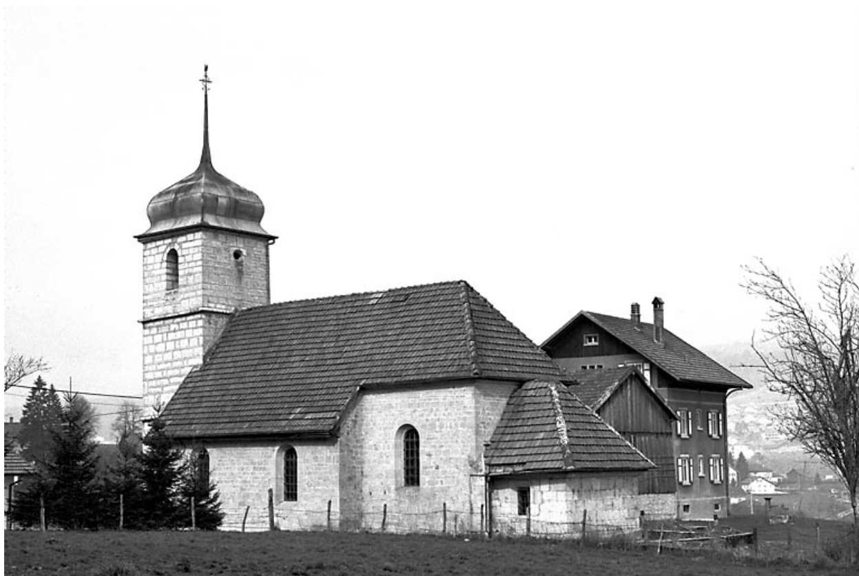
Face latérale droite vue depuis le sud-est.
