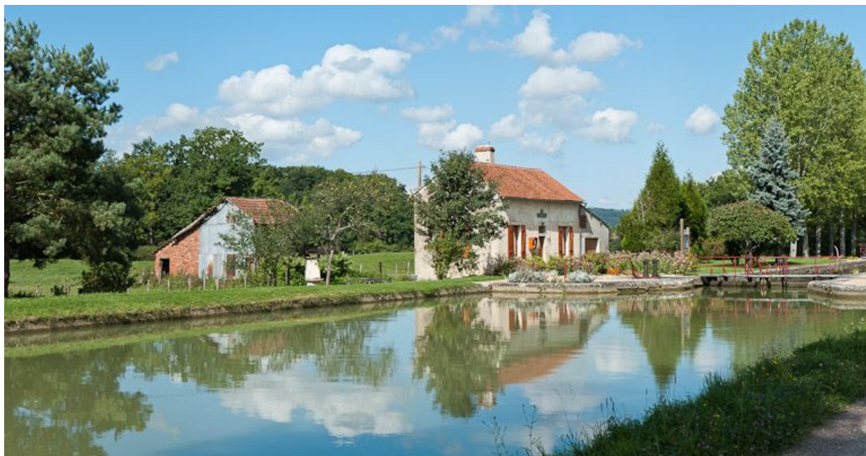
Vue du site d'écluse depuis l'amont.
