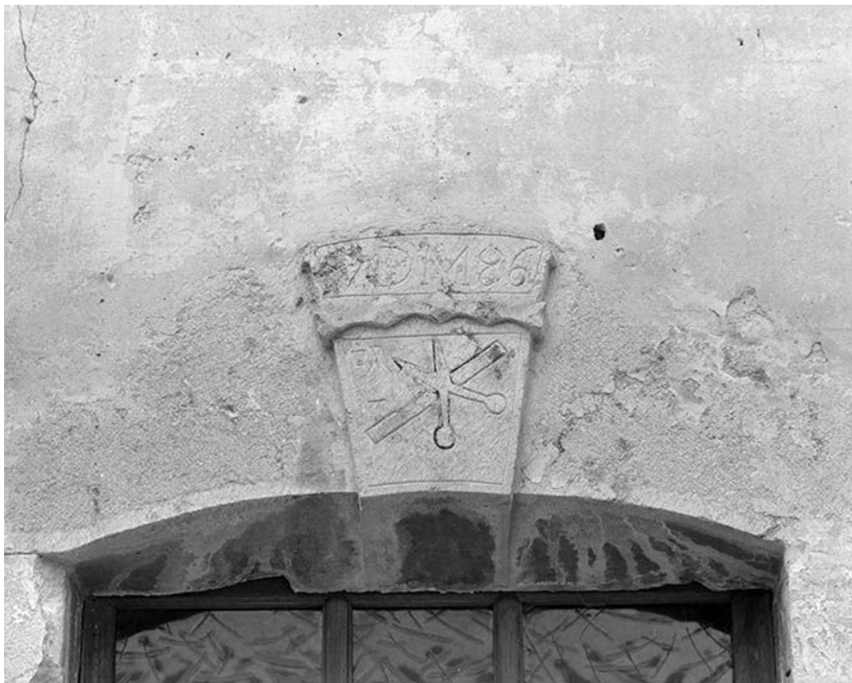
Mouthier-Haute-Pierre : maison située 11 rue du Chapitre avec linteau décoré.
