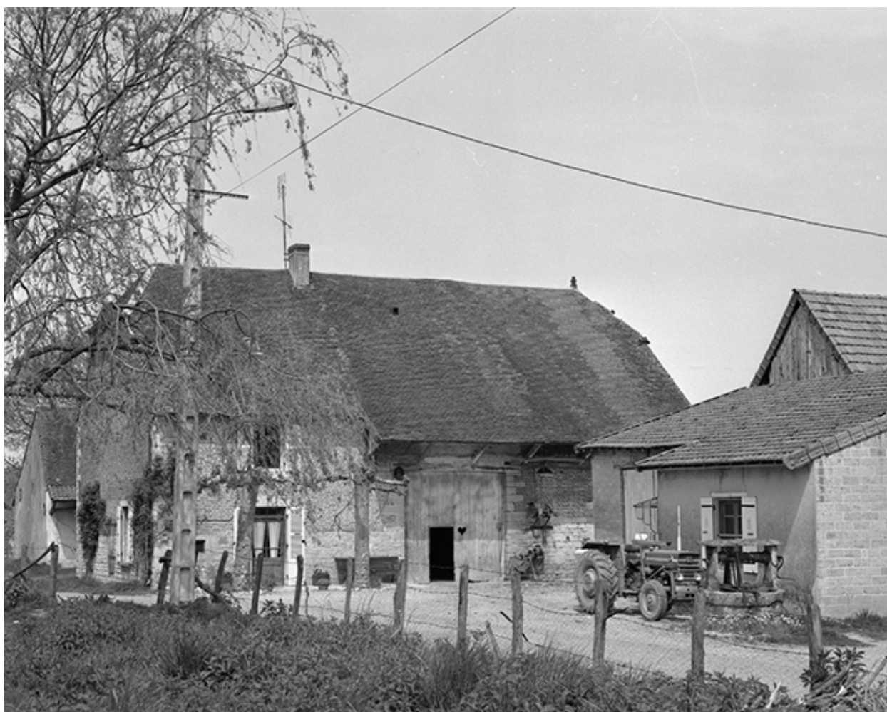
Façade antérieure et bâtiment agricole.
