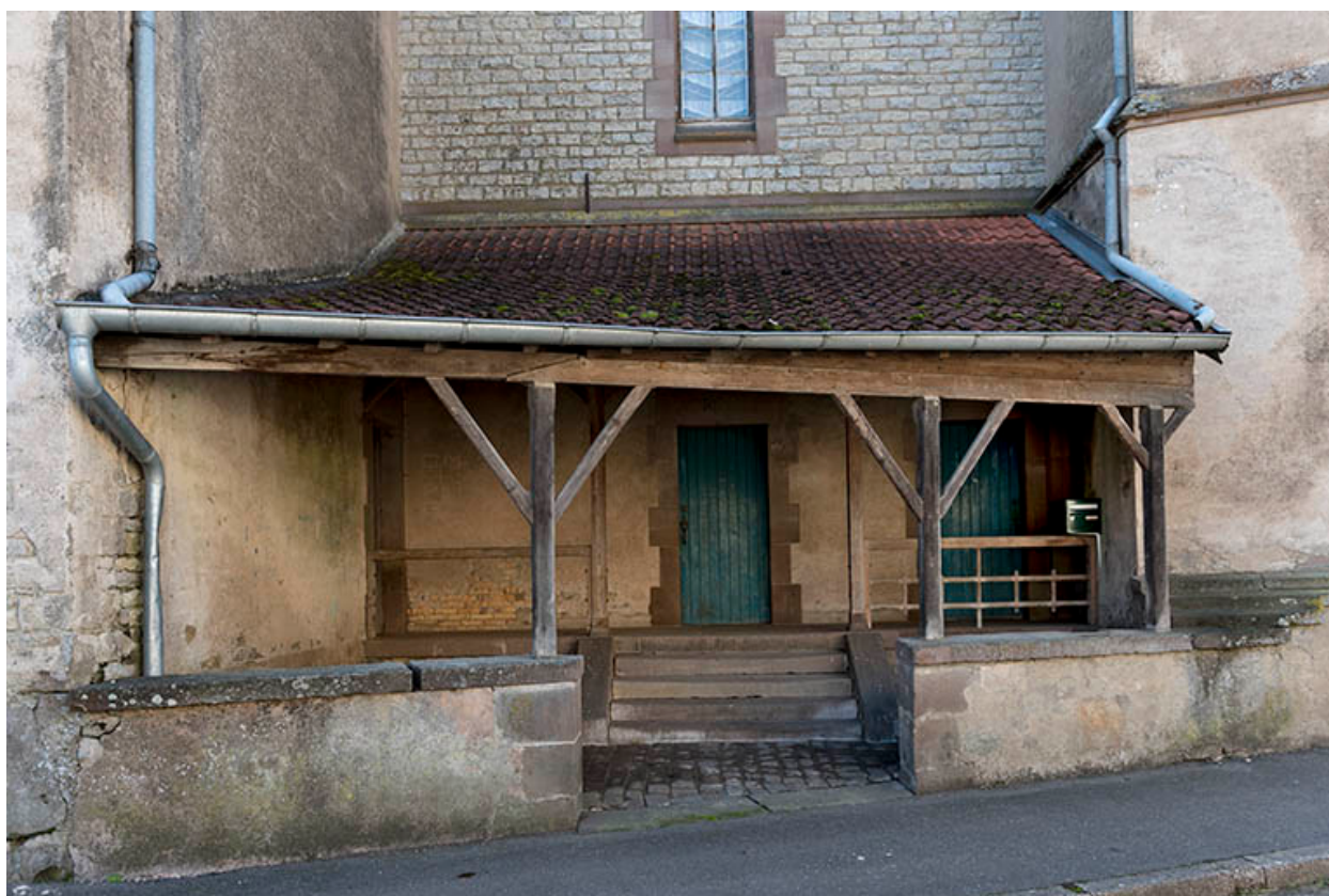
Détail de l'entrée rue Billecard.
