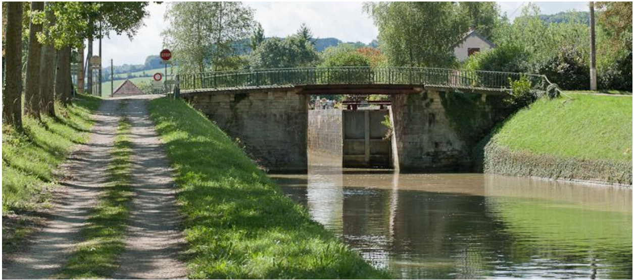
Vue du pont depuis l'aval.
