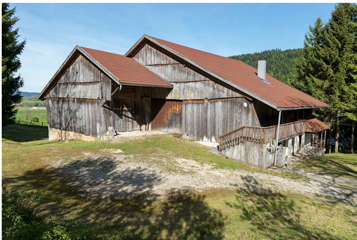
Façades postérieure et latérale gauche.
