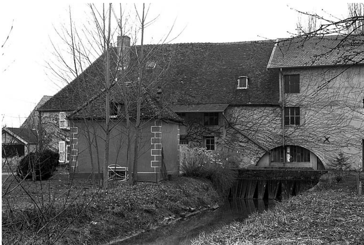
Bureau et minoterie, depuis le nord-est.
