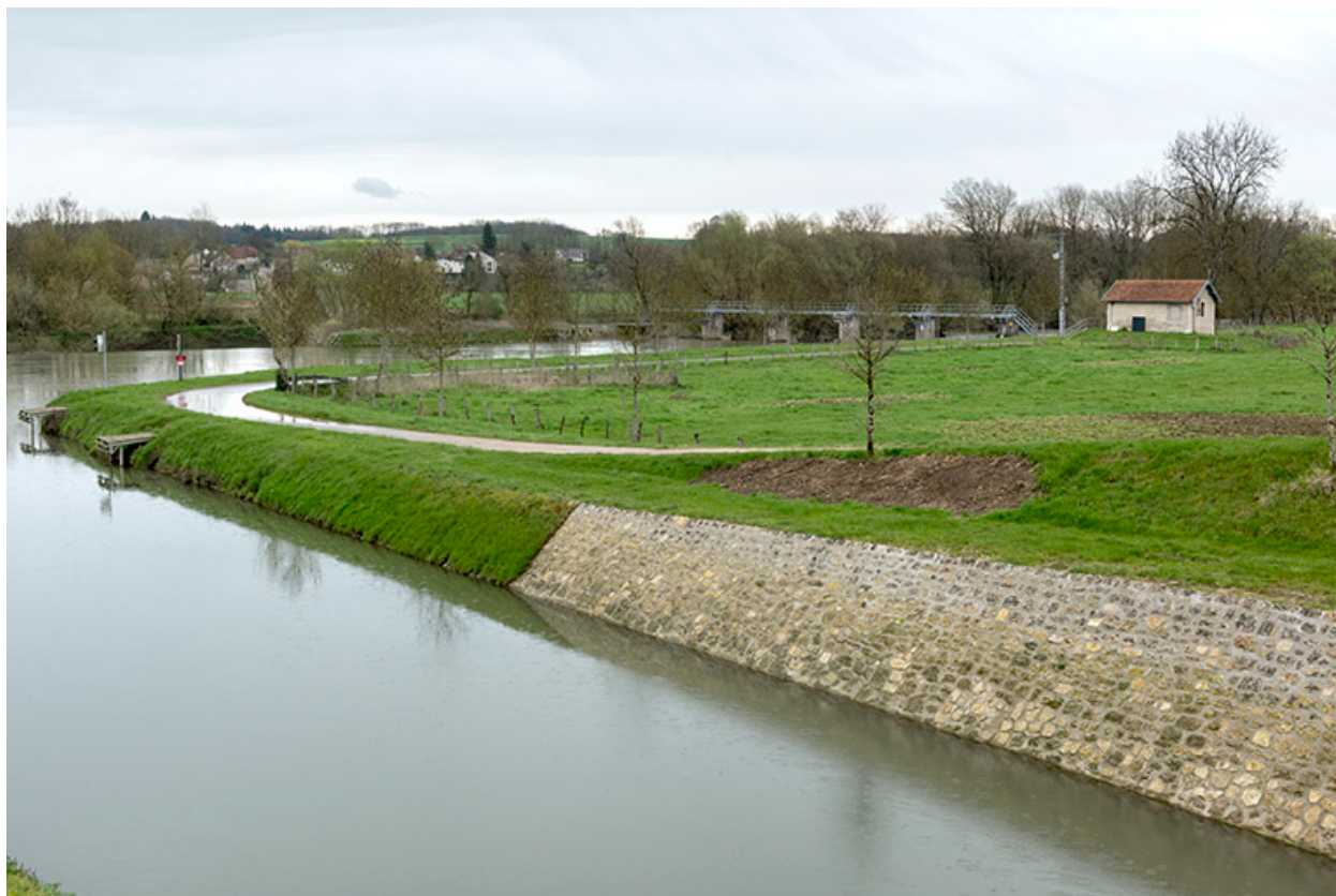
Vue depuis l'entrée amont du canal.
