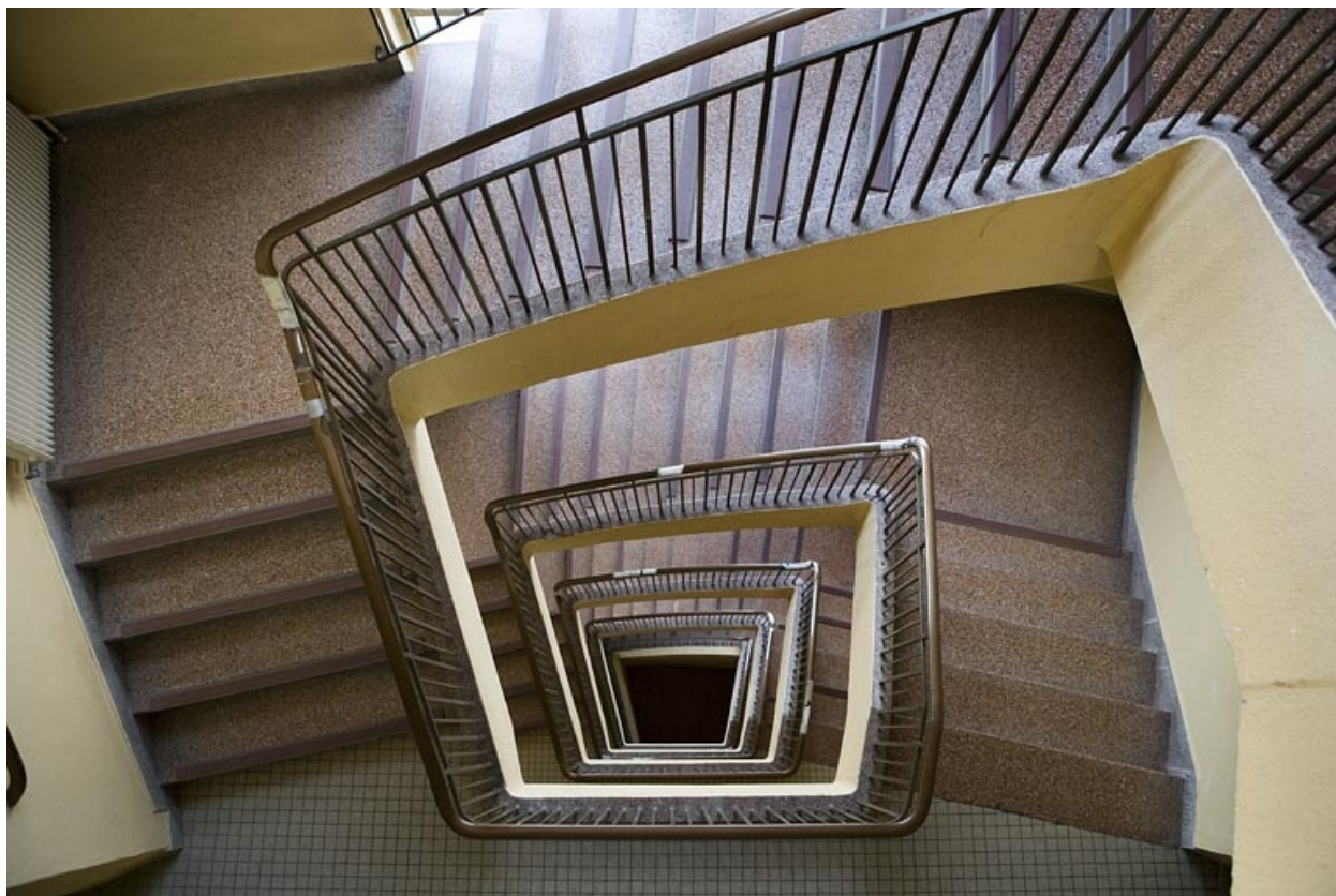
Bâtiment D : internat. Vue plongeante de l'escalier.
