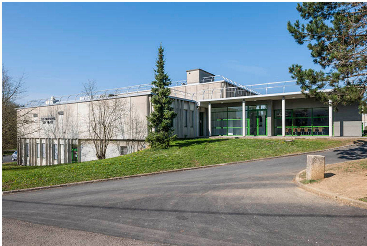
Bâtiment restauration : façade latérale.
