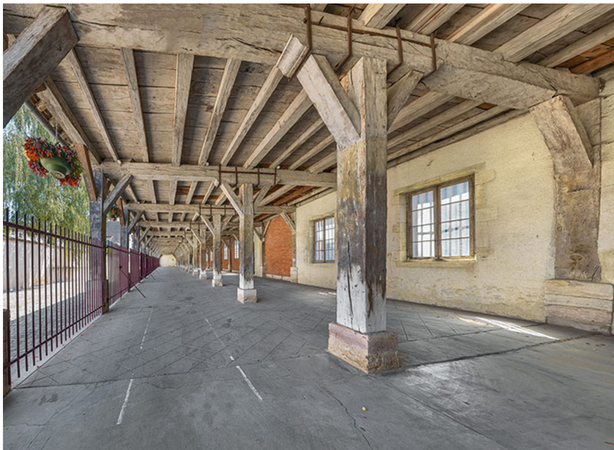
La charpente du hangar.
