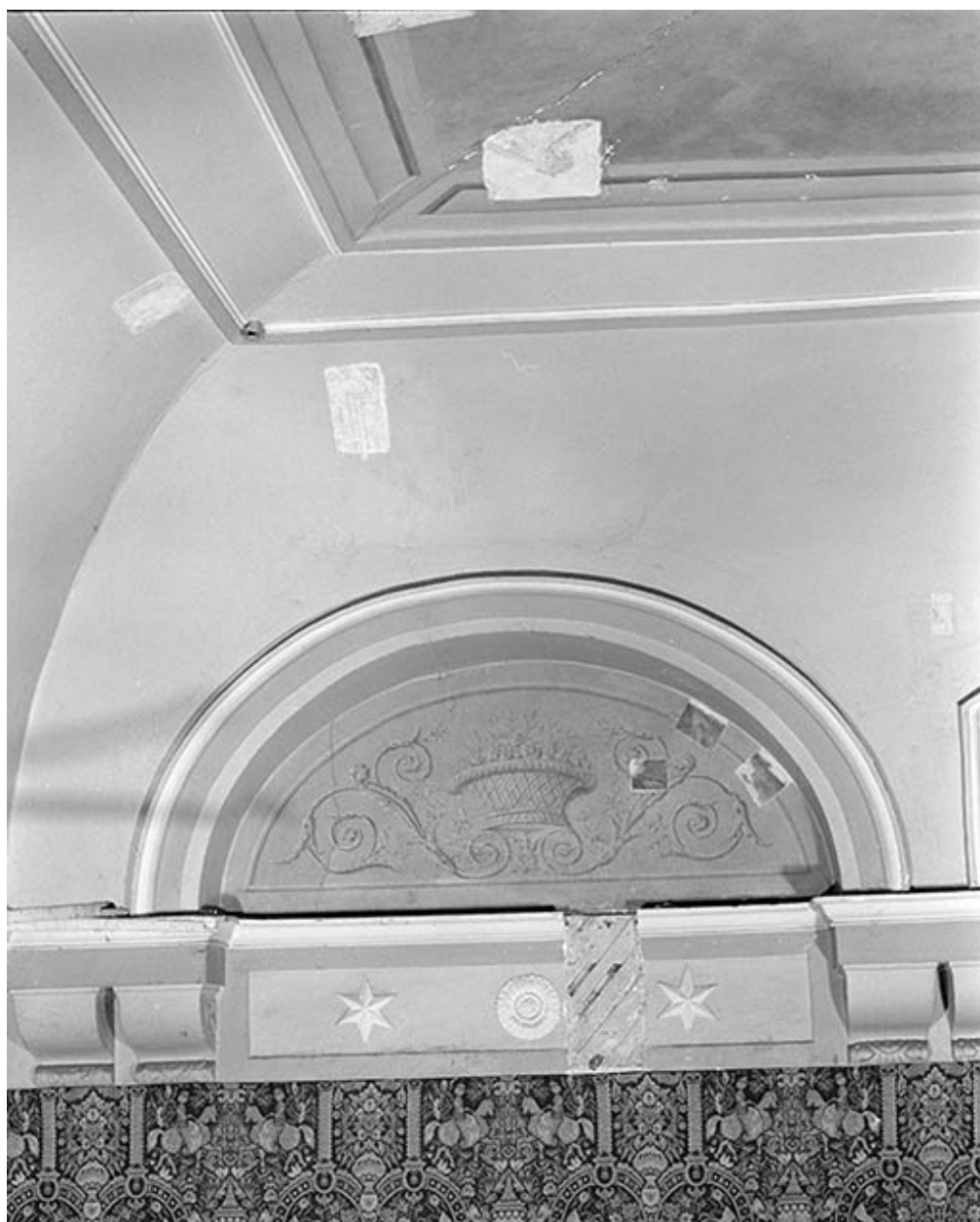
Chambre de l'Aigle, mur est, partie nord
