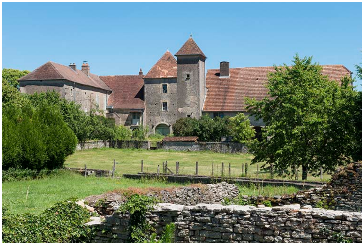
Vue d'ensemble de la maison forte.
