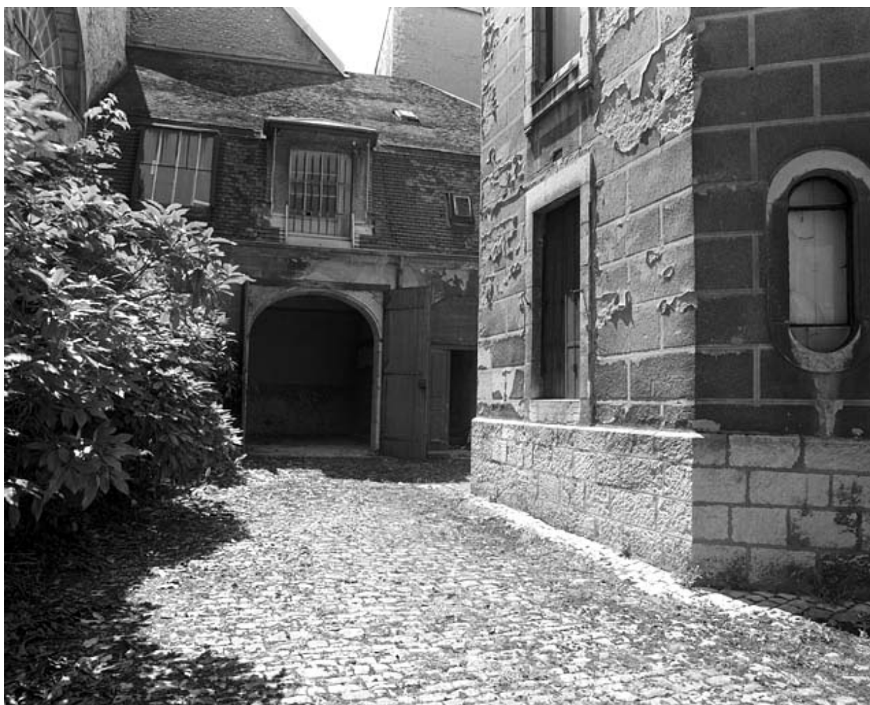
Vue du bâtiment des remises, de face.
