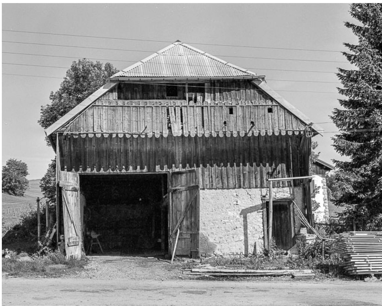
La remise, vue de face.
