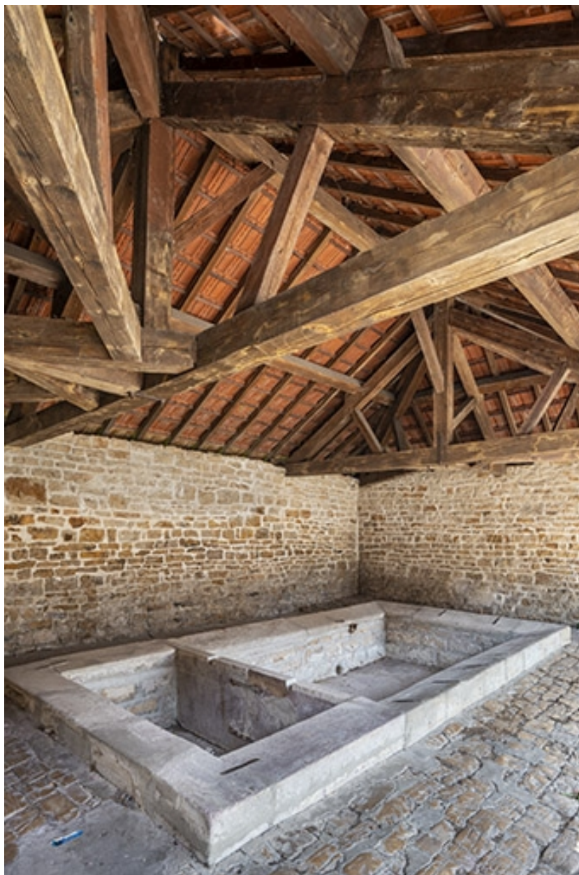
L'ensemble de l'intérieur du lavoir.
