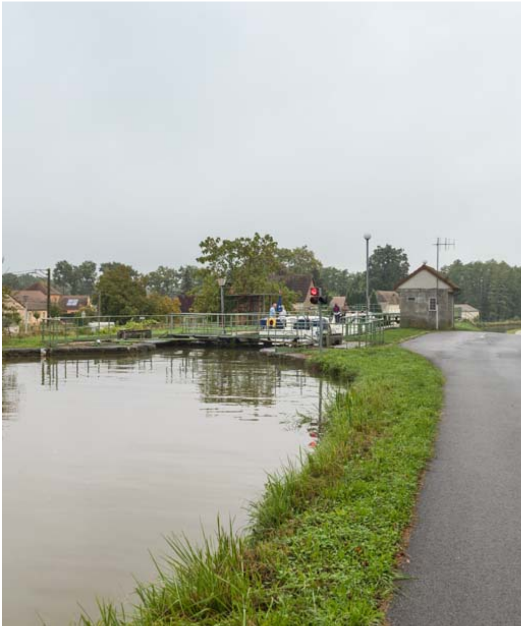
Vue d'ensemble du site d'écluse.
