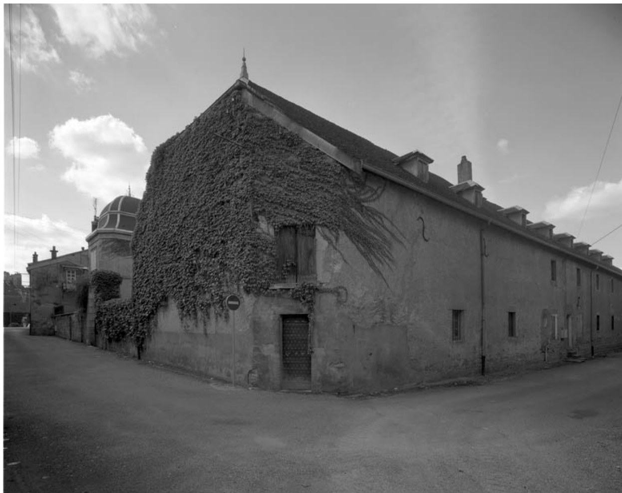
Façades postérieure et latérale droite de l'entrepôt.
