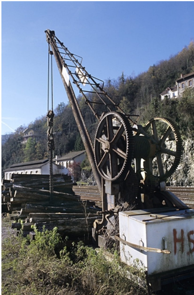
Vue d'ensemble, côté moteur.
