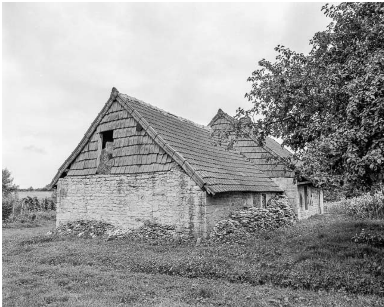
Façade postérieure et pignon droit.
