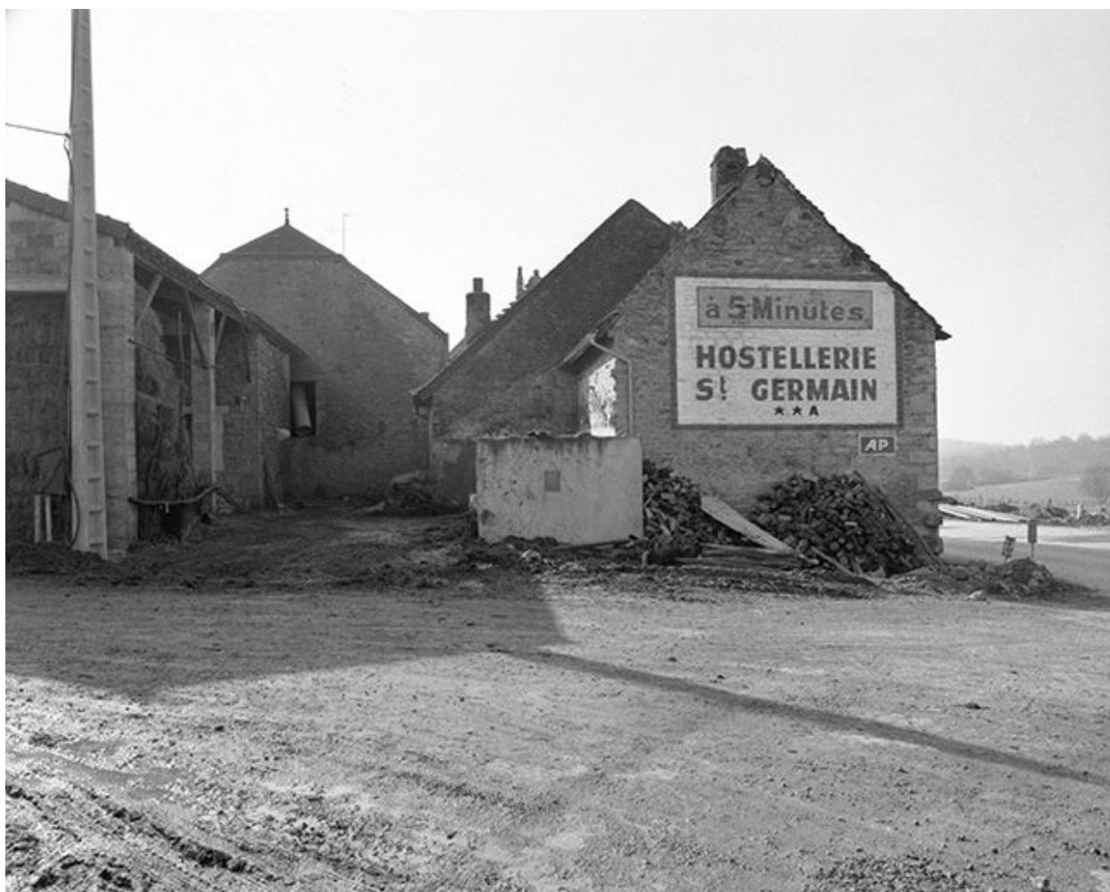
Ferme cadastrée 1959 AI 92 : façade postérieure (?).
