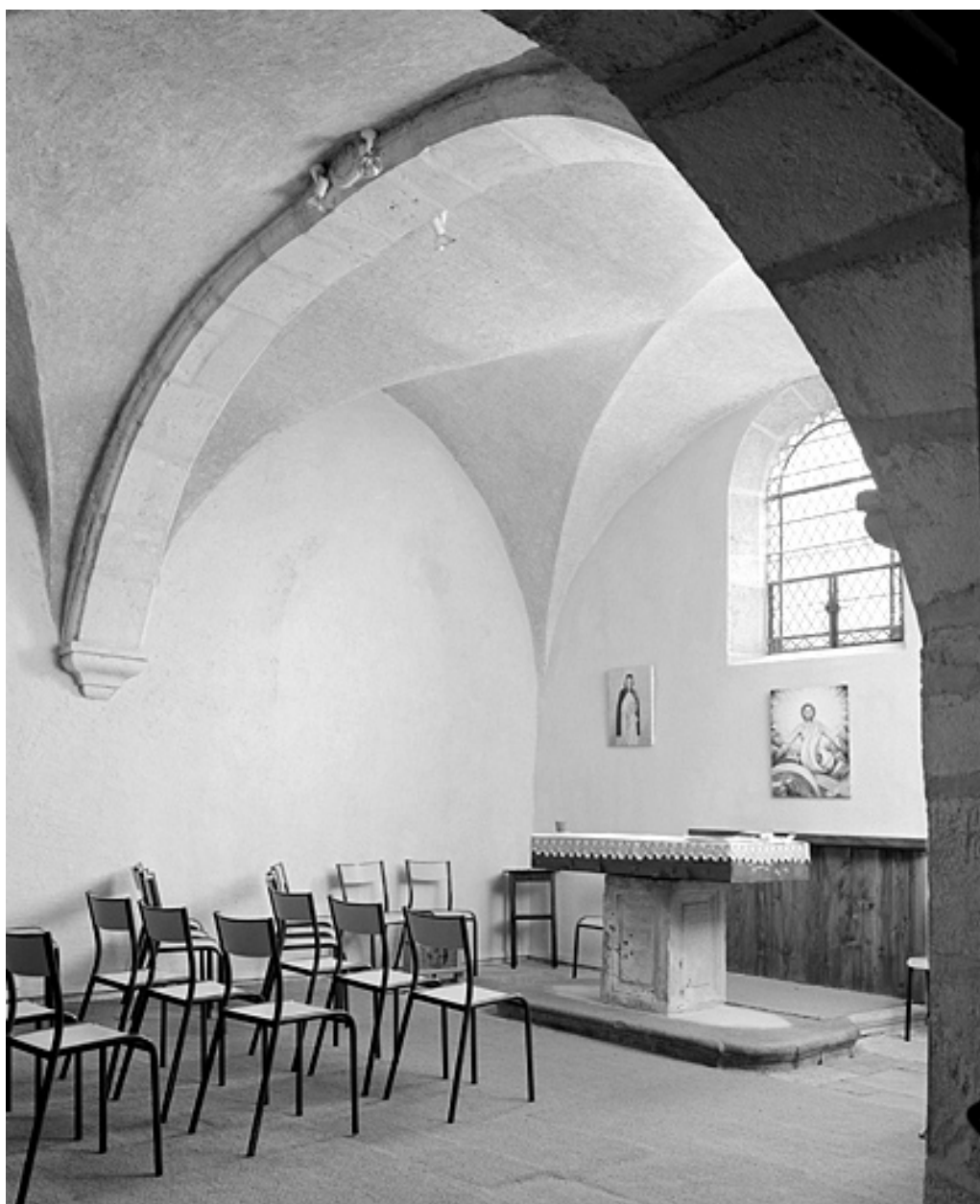
La chapelle au nord du choeur.
