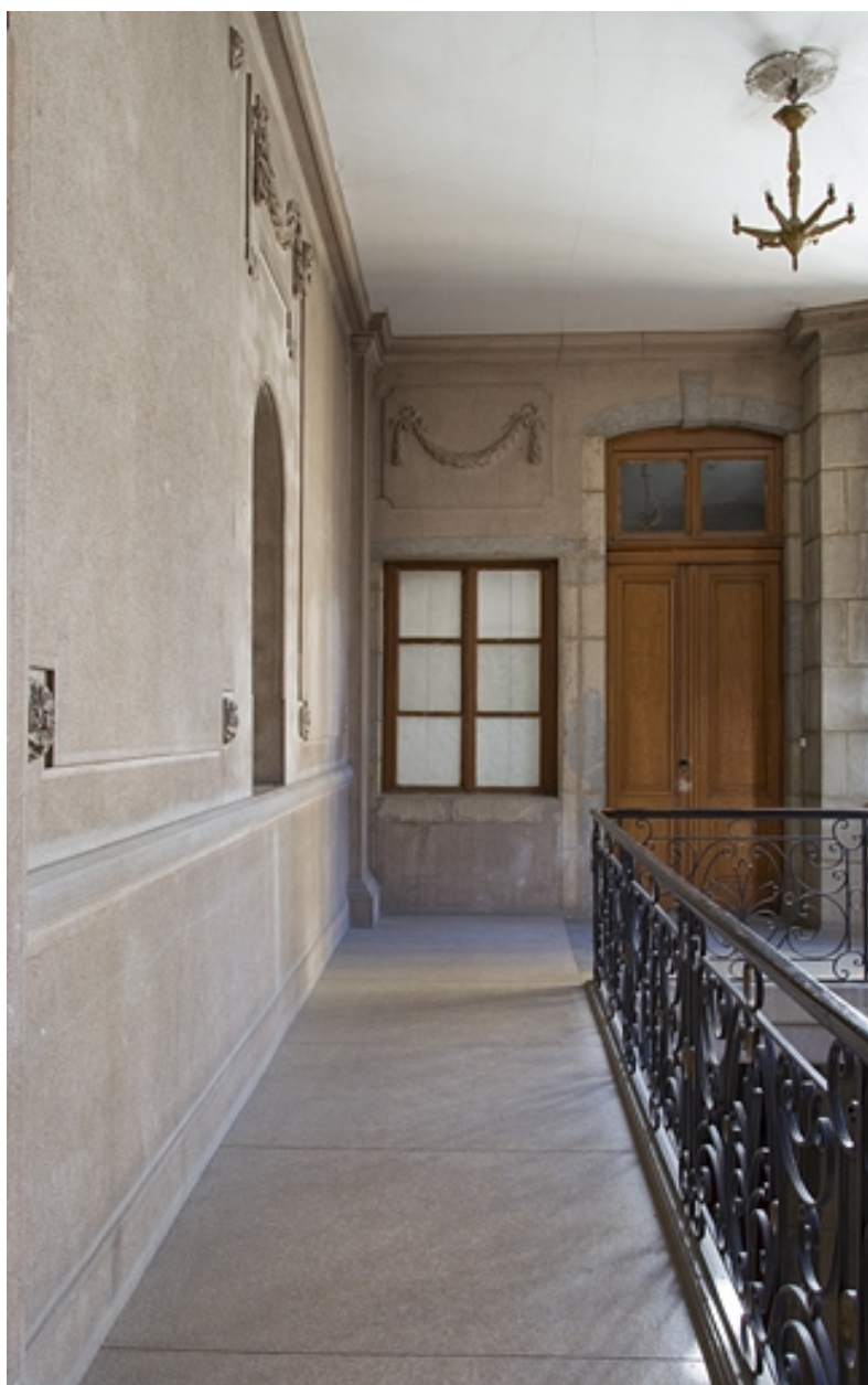
Aile de l'escalier : détail du premier palier.
