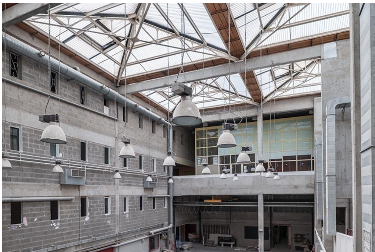
Atelier béton : intérieur, charpente et toiture.
