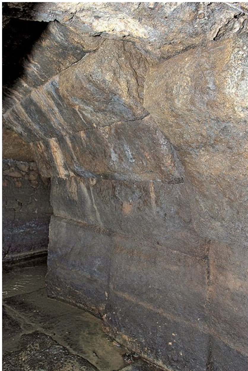
Section reliant les deux galeries.
