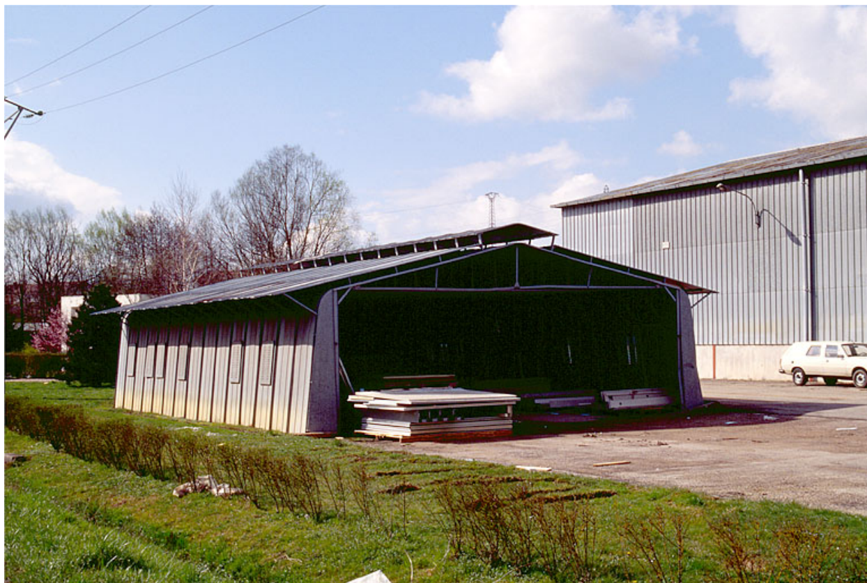
Entrepôt industriel (E).
