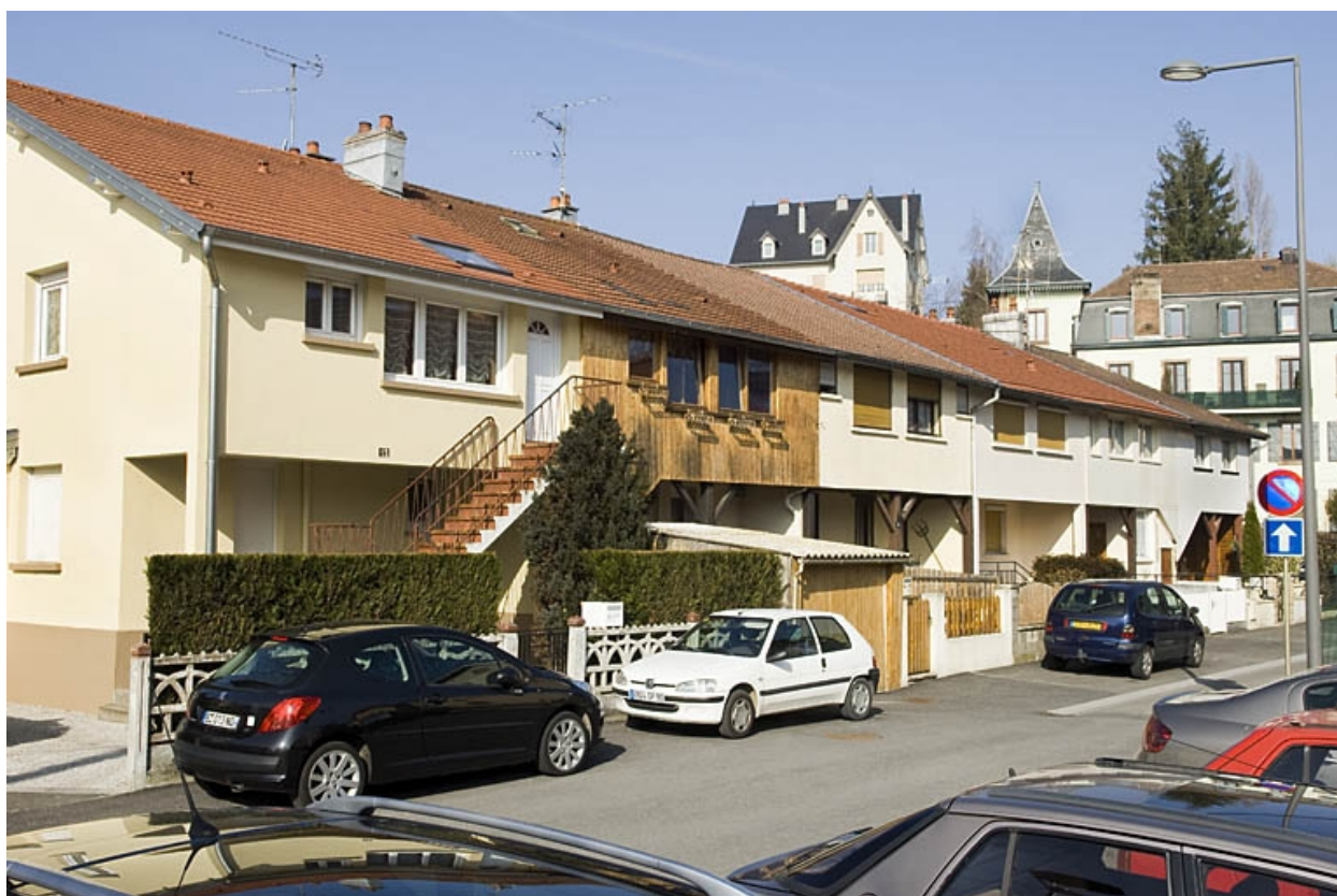
Façade sur la rue de Mulhouse.
