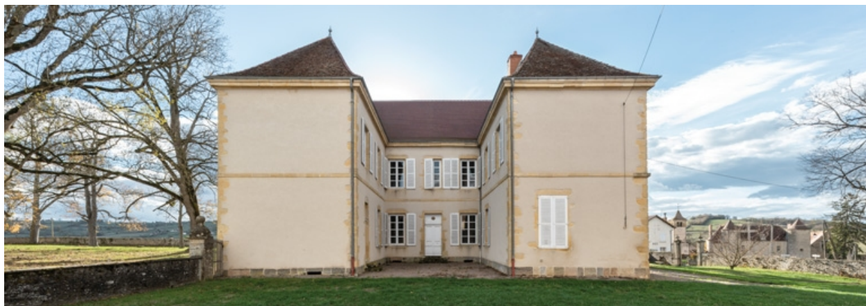
Le château vu du nord-est
