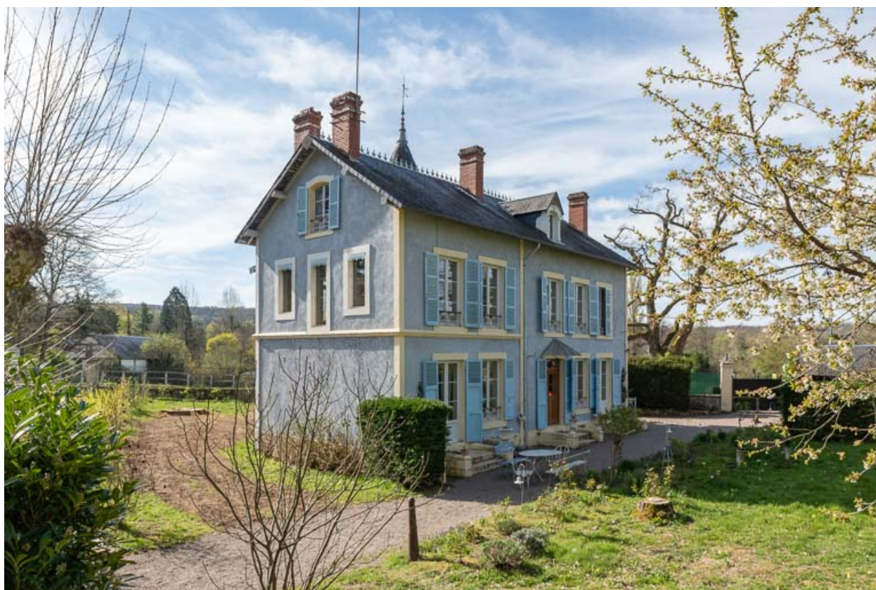
Façade nord-ouest et mur pignon nord-est.
