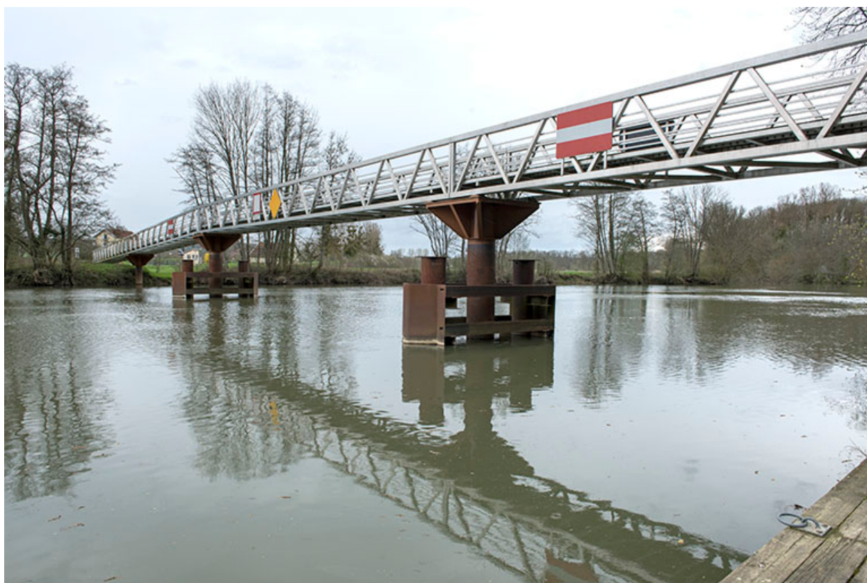
Passerelle enjambant la Saône.
