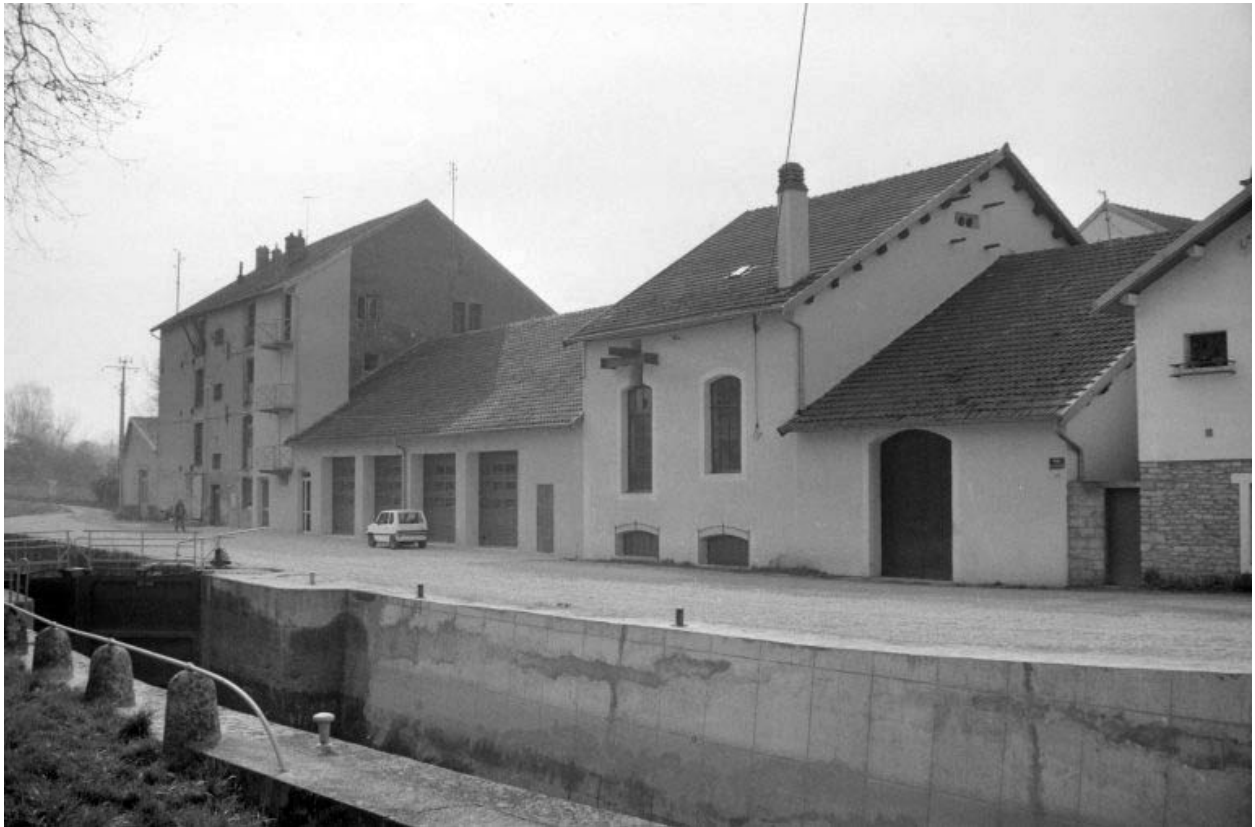
Façade antérieure vue de l'ouest.
