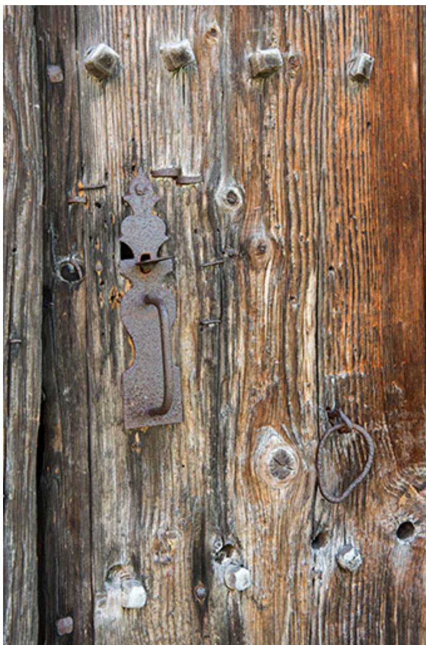
Façade ouest : détail d'une porte de grange.
