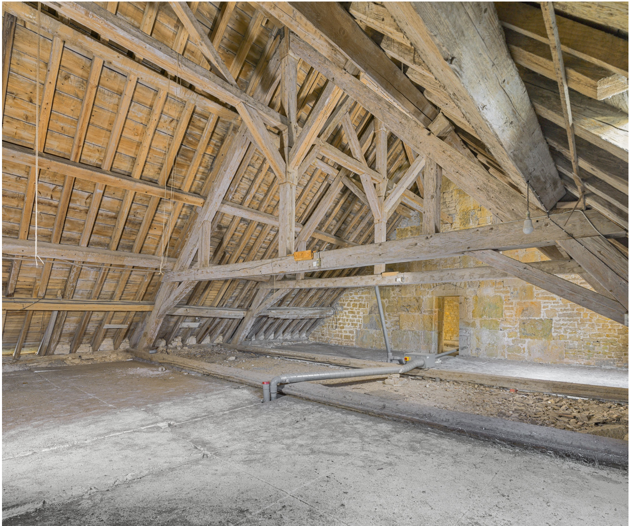
Caserne U, grenier : charpente du bâtiment.
