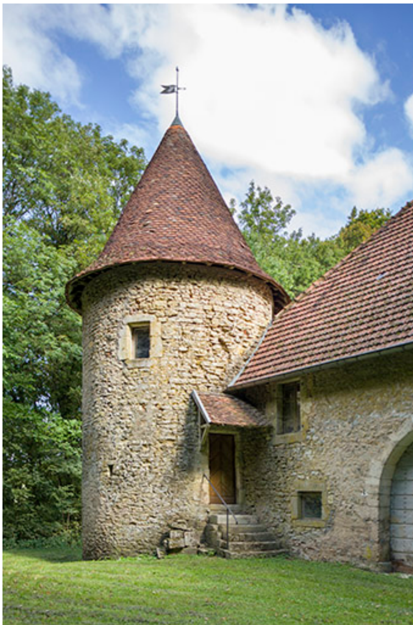
La tour à l'angle nord-est du cuveau.
