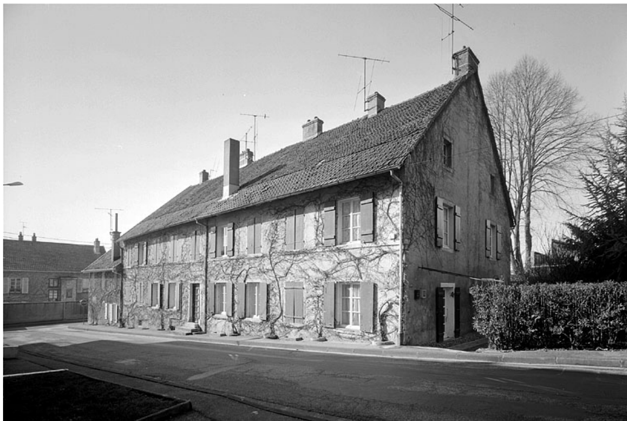
Vue d'ensemble de la façade est.
