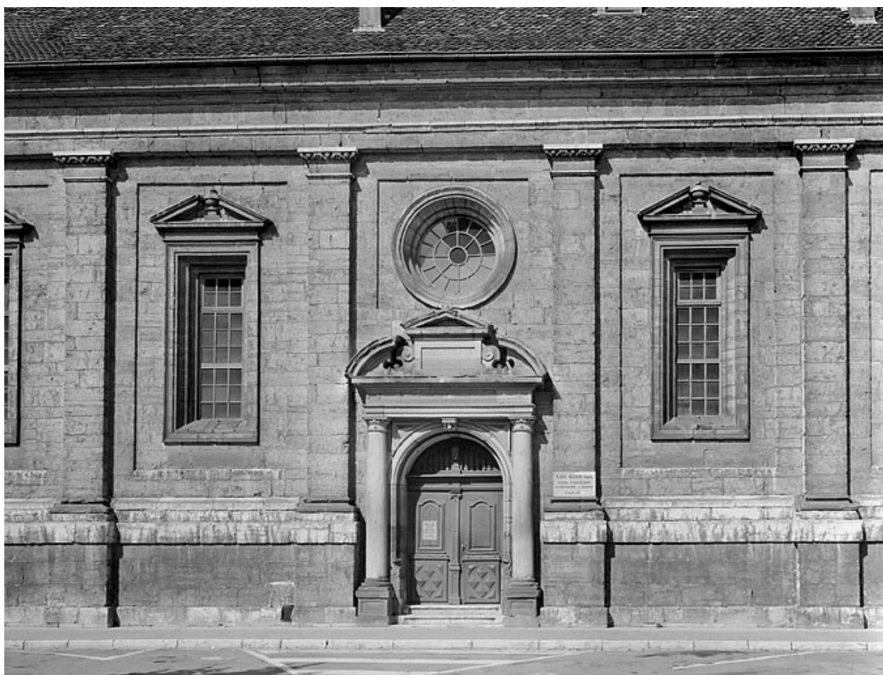
Façade sud, travées centrales.
