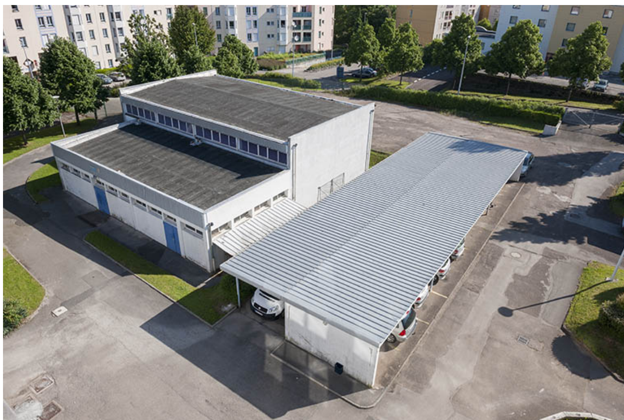
Angle sud des gymnase et garage
