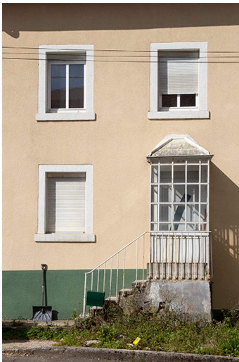
Façade antérieure : entrée.
