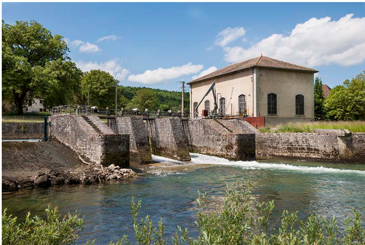
La centrale hydroélectrique et son déversoir.
