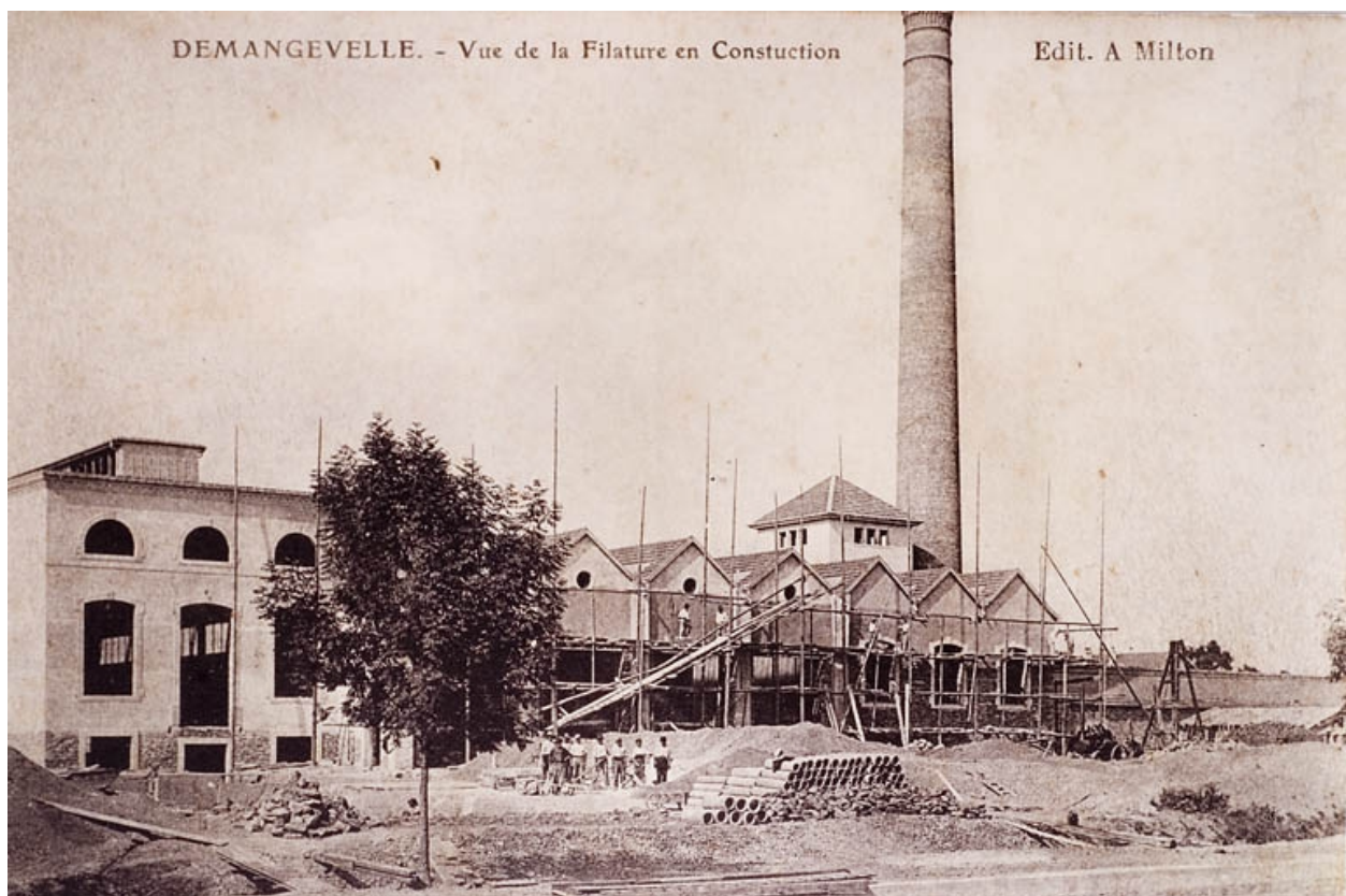
Demangevelle. - Vue de la filature en construction.
