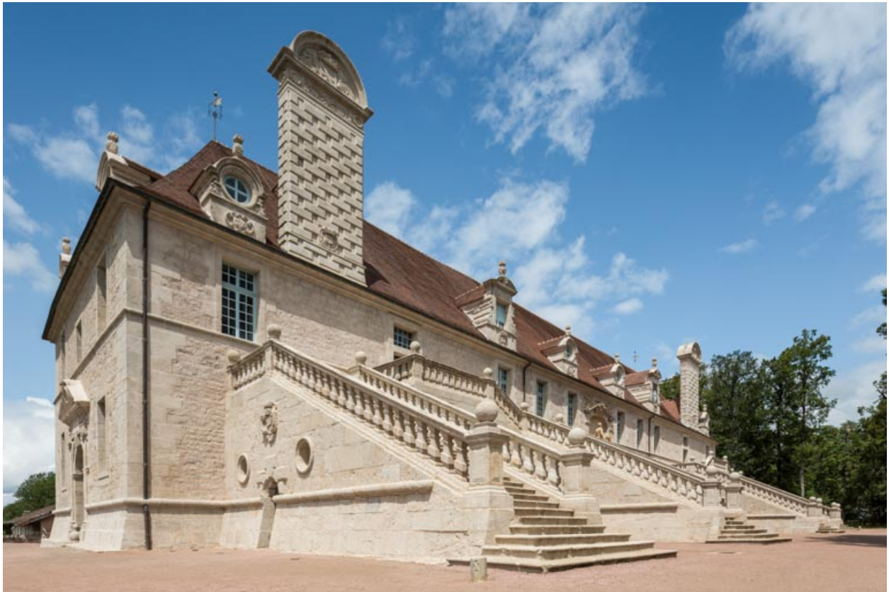
Façade sud-est, vue d'ensemble depuis le sud.
