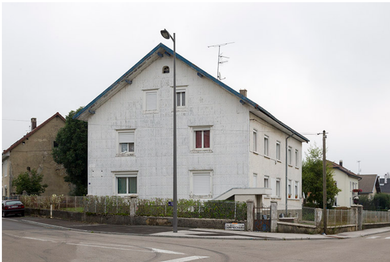
Façades antérieure et latérale gauche.
