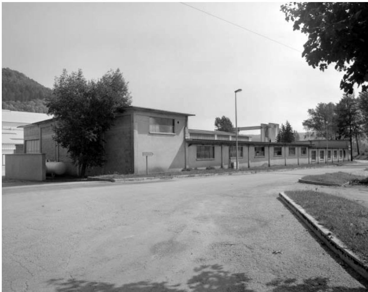
Façade ouest de l'atelier de réparation.
